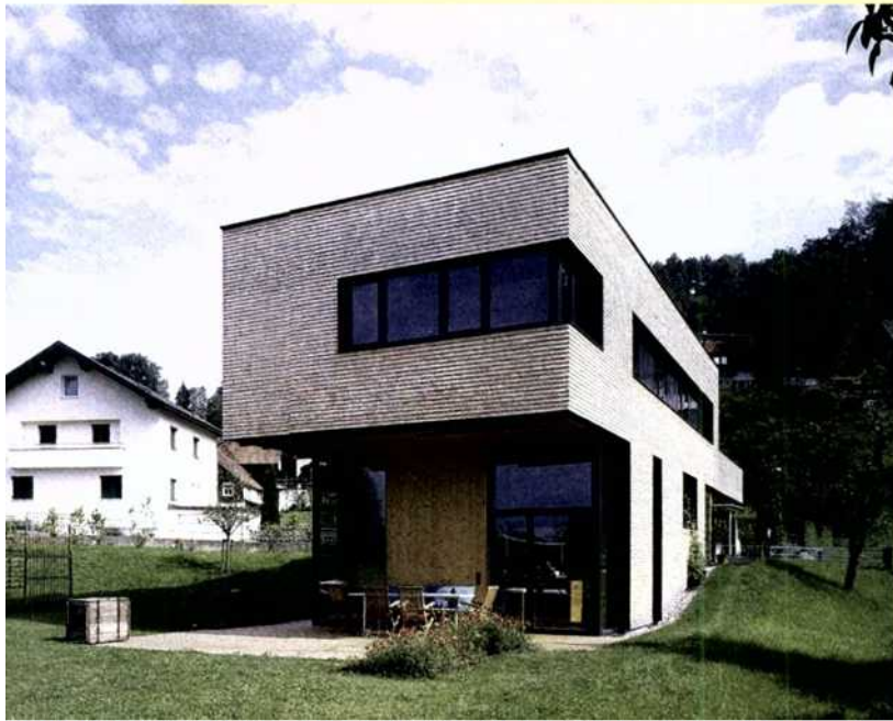
Einfamilien-Passivhaus in Wolfurt
